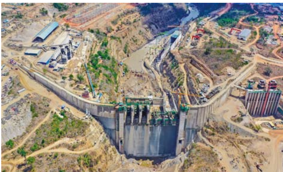
Julius Nyerere Hydropower Station eller Rufiji Hydroelectric Power Project vid Stiegler's Gorge under uppbyggnad.
