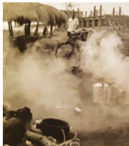
Fältkök för matlagning till byggjobbarna, 1965, foto Sven Cedergren
