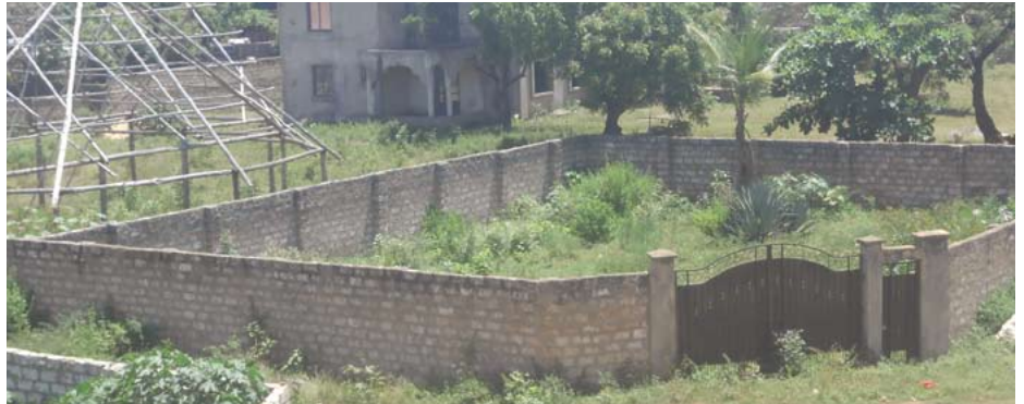
Man börjar ofta sitt husbygge med en mur runt tomten och en grind. Sedan kan tomten ofta stå obebyggd i flera år innan man kan börja med själva huset.
