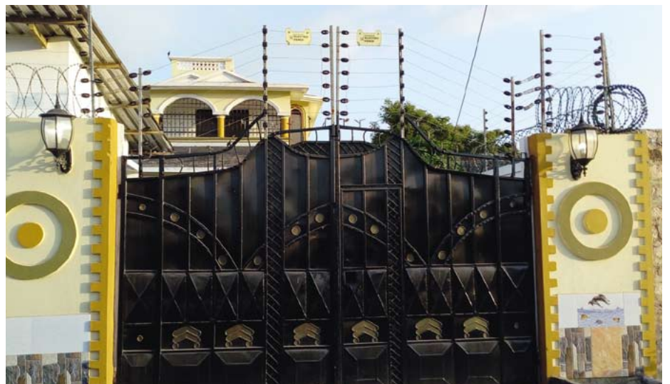
En påkostad mur och grind i den vanligaste färgen svart, komplett med el och rakbladstaggtråd. En liten skönhetsfläck är gårdshusets tak.
