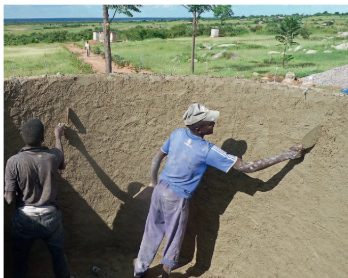
Noggrann rappning in- och utvändigt.
