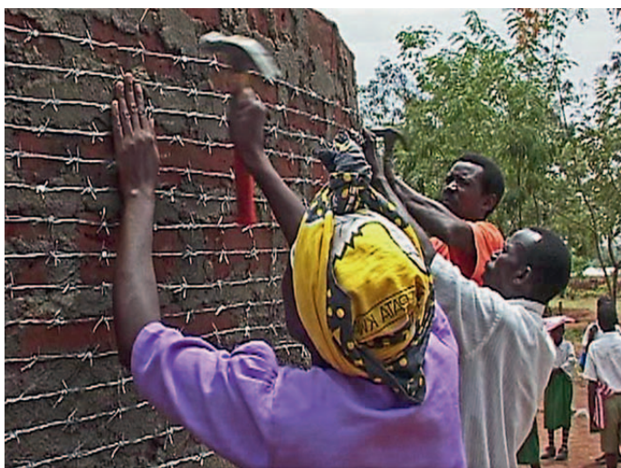
Armeringen i form av taggtråd (babudi waya = barbed wire) spänns runt tanken. Taggtråd är billigare än armeringsjärn och lättare att transportera.
