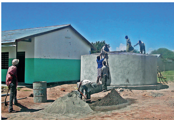
Tanken förses med ett välvt gjutet tak.
