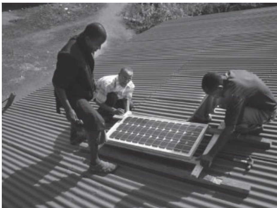
Installering av solceller på en hälsoklinik i Muheza
