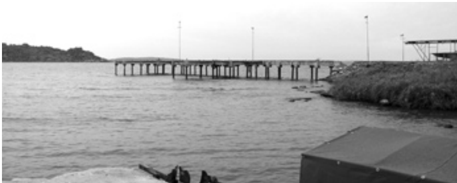
Vattennivån har sjunkit kraftigt under 2000-talet
