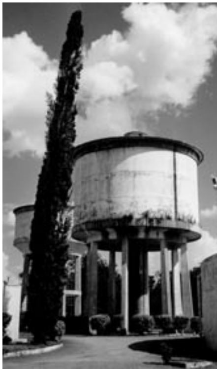
I det stora vattenverket renas vattnet som kommer från flera stora dammar runt omkring Mwadui. Här finns både markreservoarer och vattentorn. Processvattnet i diamanutvinningen återcirkuleras i stor utsträckning.
