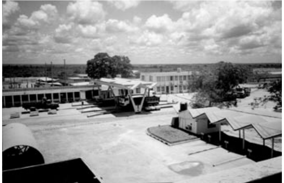
Fordonsvågar i entrén till Tanzania Portland Cement. Under briståren var här ständiga köer av lastbilar som väntade på den åtråvärda varan. Köerna, cementspill och kraftigt dammerfall från ugnarna är numera obehagliga minnen.
